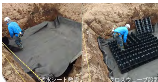
豪雨に備える雨水貯留・浸透槽「クロスウェーブ」 写真は実際の施工の様子です。
